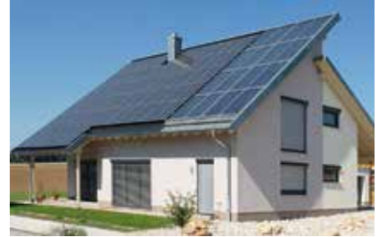
Solarthermie-Flachkollektoren rechts, links PV-Module
