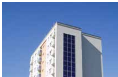
Solarthermie-Flachkollektoren am Mehrfamilienhaus
